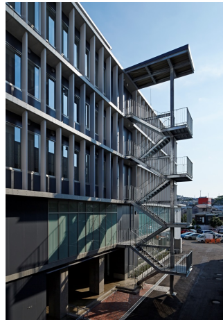
5号館外観(北面)*
