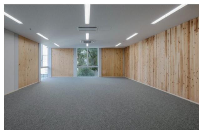
兵庫県林業会館におけるCLTパネル利用
