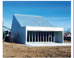
■再生可能エネルギー環境試験建屋 (REハウス)
