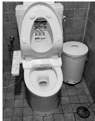
写真3 トイレの床面に設置された清掃排水用の床排水トラップの例(大塚)
